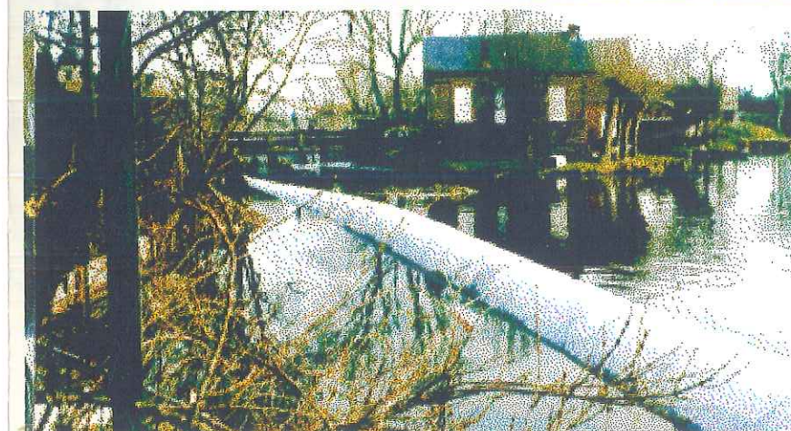
Mise en place de la buse canalisant les sources
